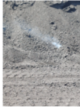
תמונות 1-4: בעירות פנימיות בערימות הפחם באתר "אורות רבין" שאותרו במהלך סיורי הפיקוח, וביצוע הרטבת הערימות למניעת בעירות אלה.
